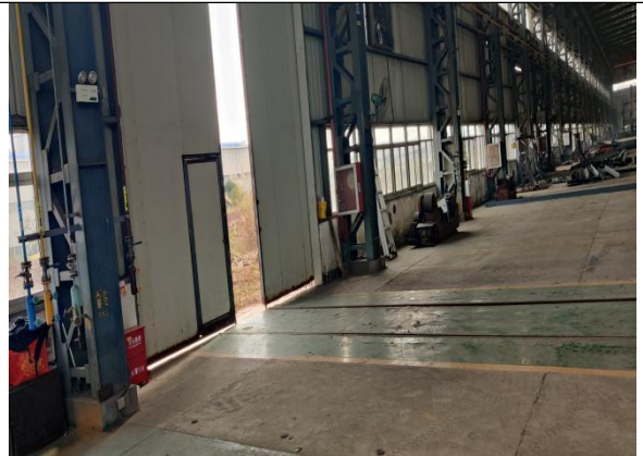
图 1-2 探伤房拟建址南侧
